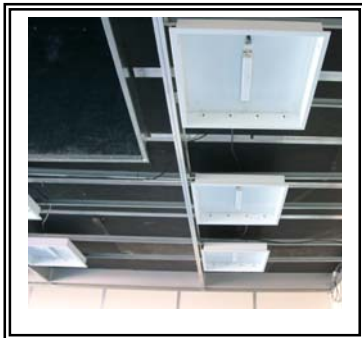
Exemple d'un calpinage de pavés lumineux BARRILEC réf. série B540/50 incorporés dans un plafond BARRISOL
